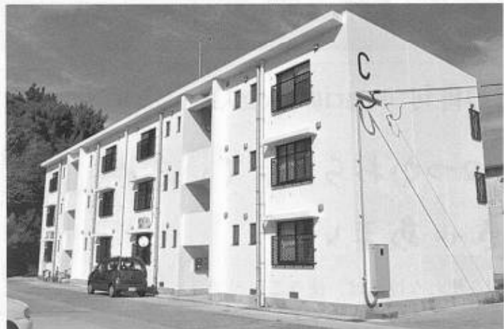
阿多野平住宅C棟
