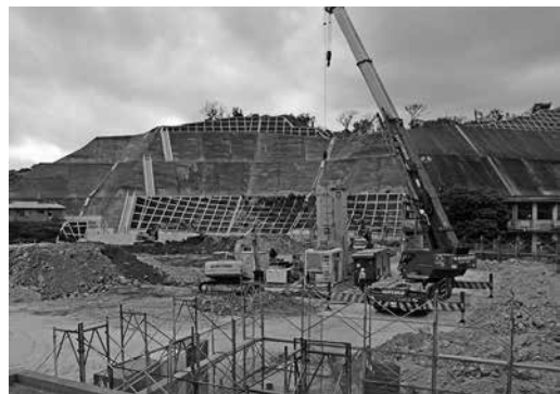
亀津中学校建設事業建設現場
