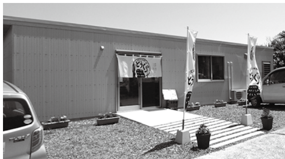
泊食分離施設整備事業（金見ジビエカフェとうぐら）
