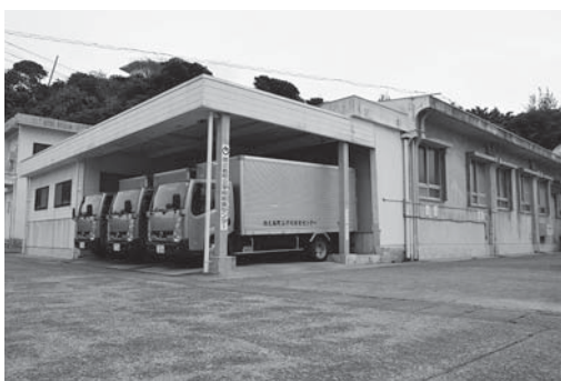
老朽化の進む町給食センター
