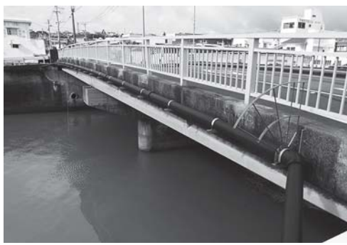
亀津新大瀬橋橋梁添架配水管
