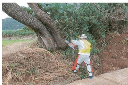
道路沿いの枯れ松伐採作業
