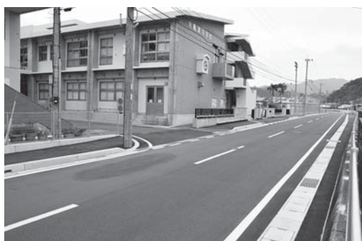
道路拡張工事で広々した亀津中学校前
