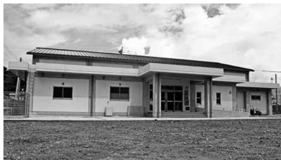
亀津中学校武道館建設事業
