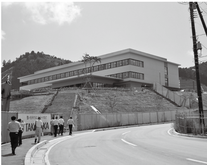
完成間近の女川町役場
