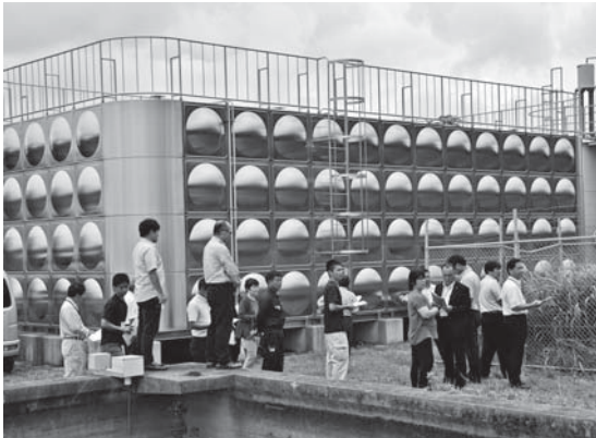
新設された母間浄水場の貯水タンク
