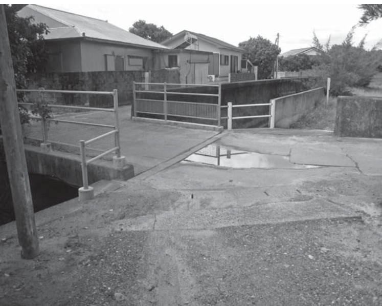
緊急車両の通行が困難なカーブ
