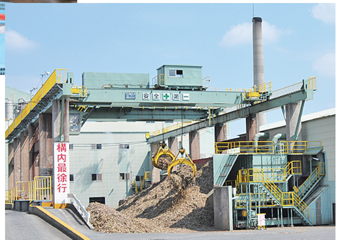
サトウキビが搬入される製糖工場
