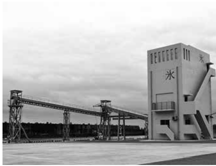
新たに整備された大型製氷貯氷施設
