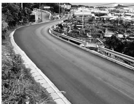
舗装補修工事が施工された亀津中央線
