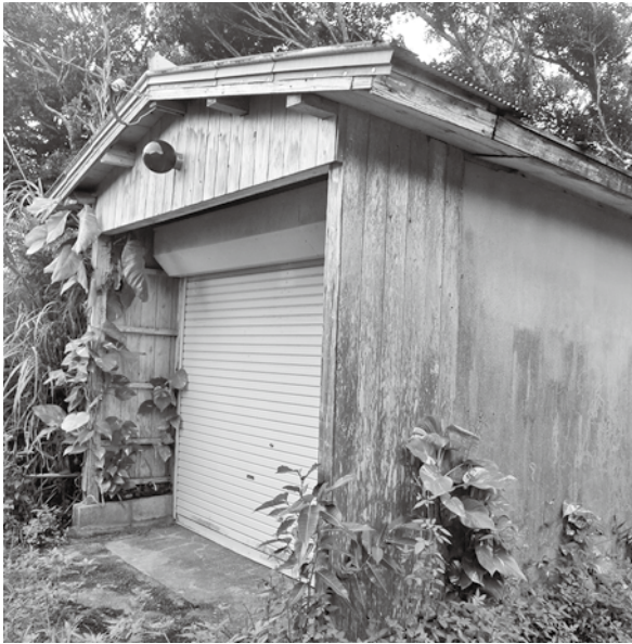
老朽化した尾母消防車庫
