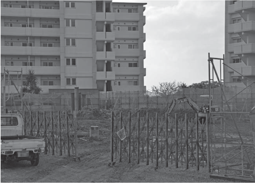
小郷団地 5 号棟の建設現場
