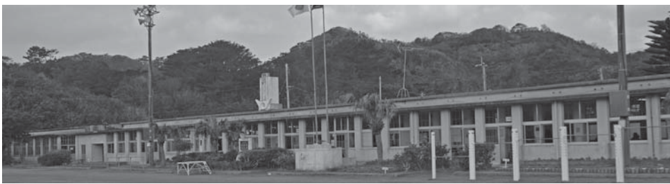
学校再編と老朽化で新築が待たれる東天城中学校
